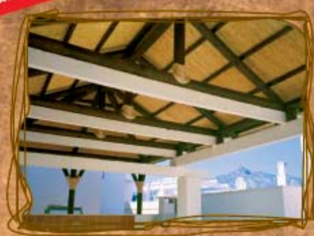
Terminación Cañizo y hormigón armado
