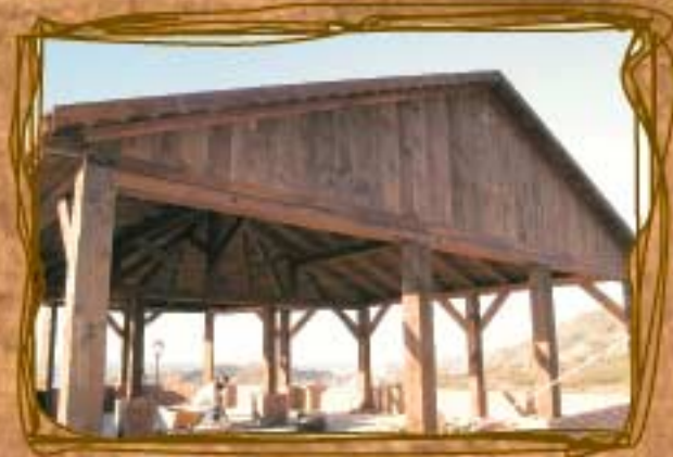
Pérgola en Patio
