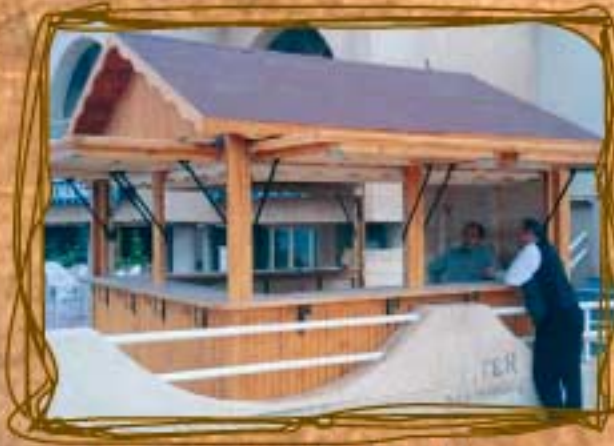
Pérgola Terminada en Kiosco
